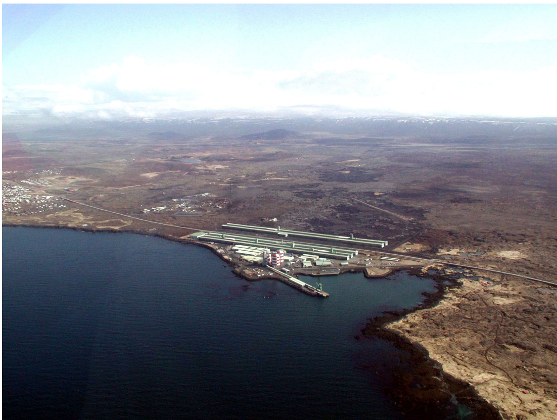
Mynd 20.14 Ljósmynd af álveri ISAL og fyrirhugaðri stækkun þess, séð úr lofti til suðurs.
